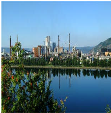
Herøya Industripark har mye spillvarme
