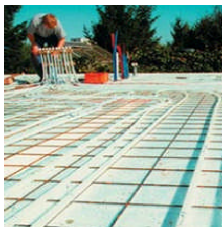
Legging av vannbåren gulvvarme
